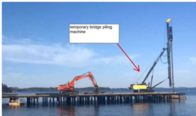
FOTO 4-3. ILLUSTRATIIVNE NÄIDE EHITUSAEGSEST AJUTISEST VAIADEL SILLAST.
