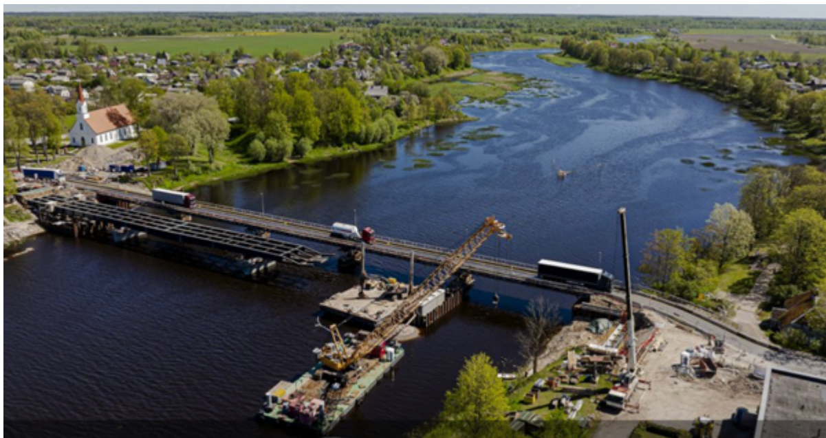
FOTO 4-1 NÄIDE AJUTISE EHITUSKAEVIKU - KESSOONI LAHENDUSENA SILLASAMBA RAJAMISEST SALATSI JÕELE VIA BALTICA UUE SILLA EHITUSEL, 2025. FOTO: RENARS KORIS/LVC 3 .
