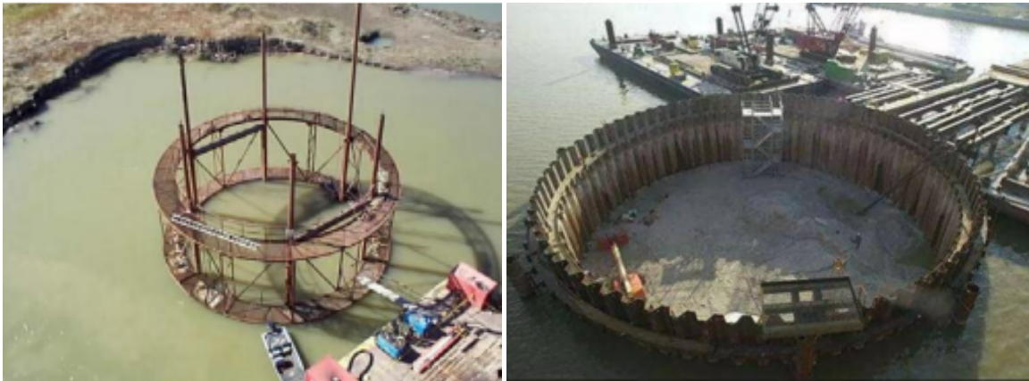
JOONIS 4-6 NÄITED KOFERDAMI TUGIRAAMI PAIGALDAMISEST JA VALMIS KOFERDAMIST, MILLISEST ON VESI VÄLJA PUMBATUD
