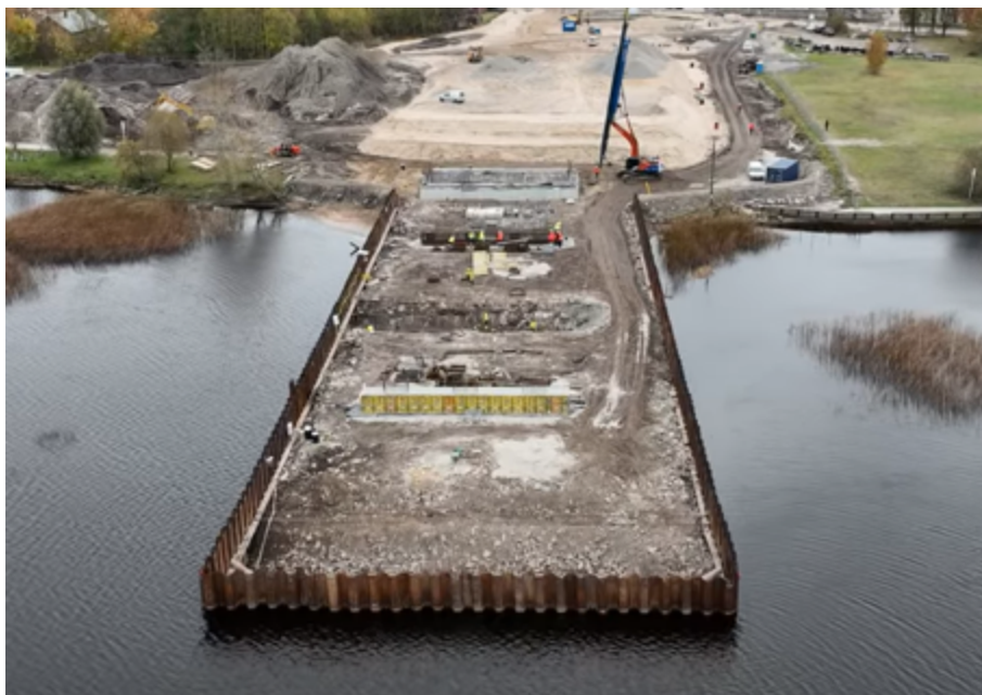
JOONIS 4-5 NÄIDE SULUNDSEINTEGA AJUTISEST TAMMIST
